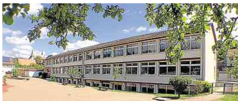
Die Monzinger Grundschule wurde in vergangenen Jahren baulich und energetisch auf den Stand der Technik gebracht. Weitere Investitionen folgen.
